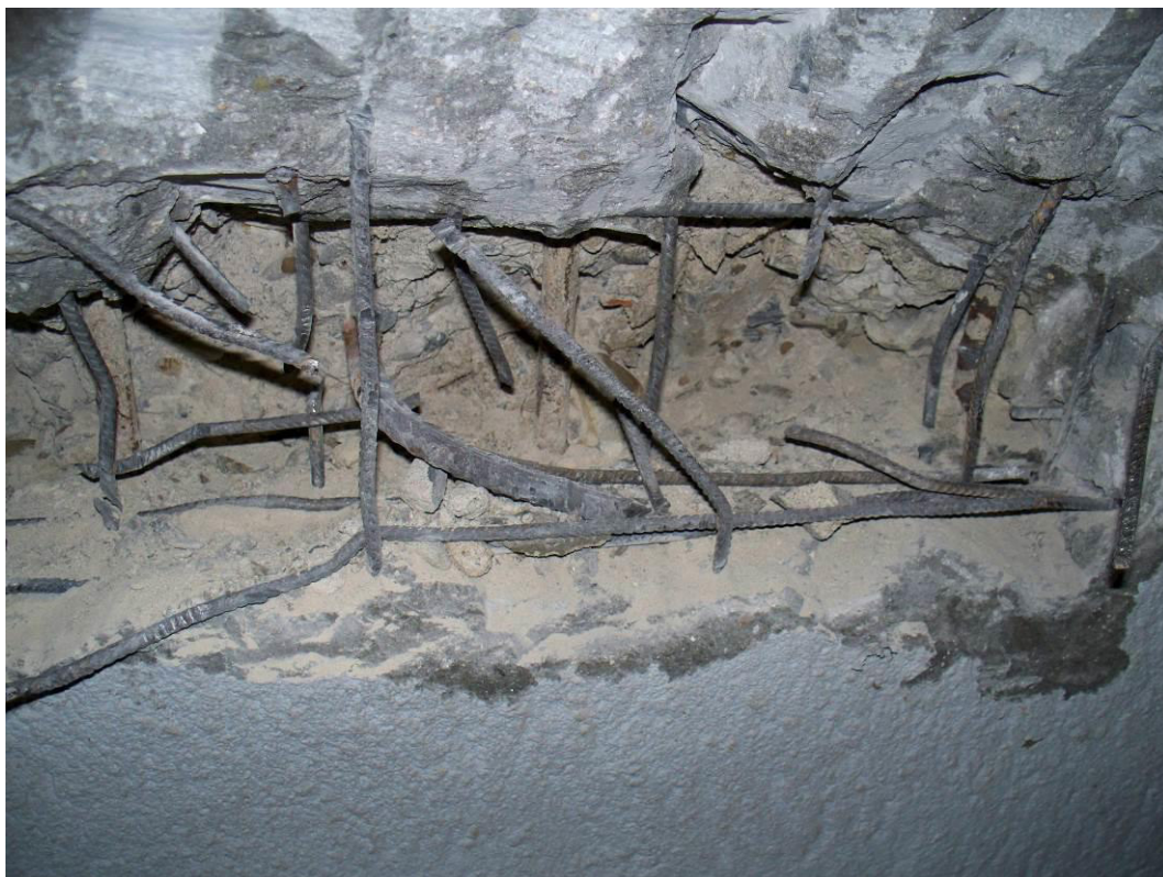
Obr. č. 11 – pohled na odhalenou výztuž
