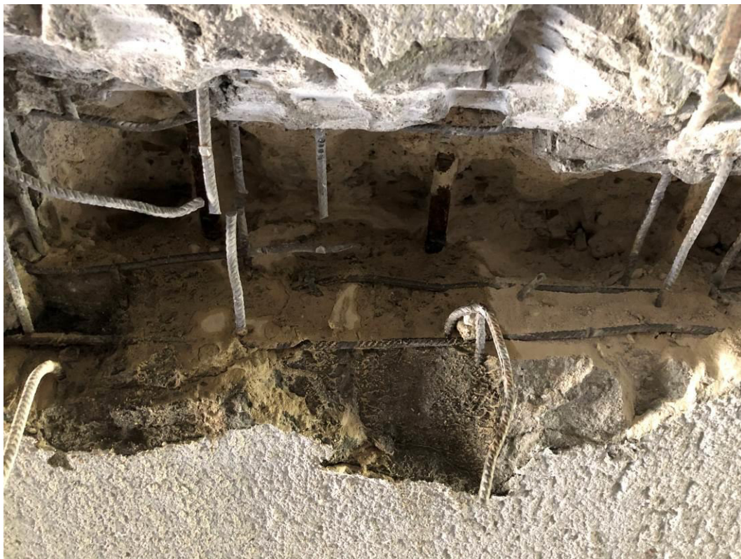
Obr. č. 10 – pohled na odhalenou výztuž
