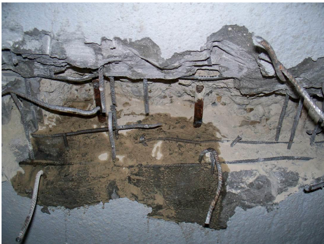
Obr. č. 12 – pohled na odhalenou výztuž
